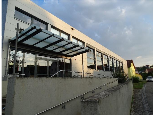
Abb. 7: Turn- und Festhalle aus Richtung Osten
